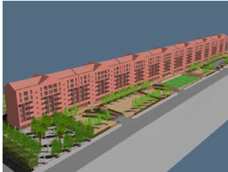
Alloggi di via A. Rizzo
