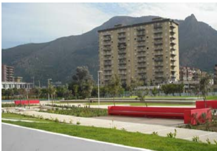
Area verde in costruzione a Bonagia
