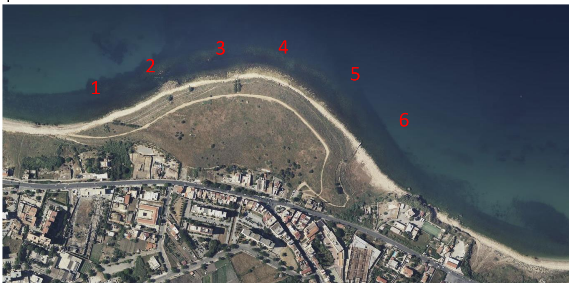
Figura 3. Vista panoramica area di messa in opera delle barriere sommerse realizzate.
