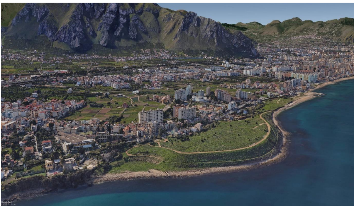
Figura 1 – Vista panoramica area di intervento
