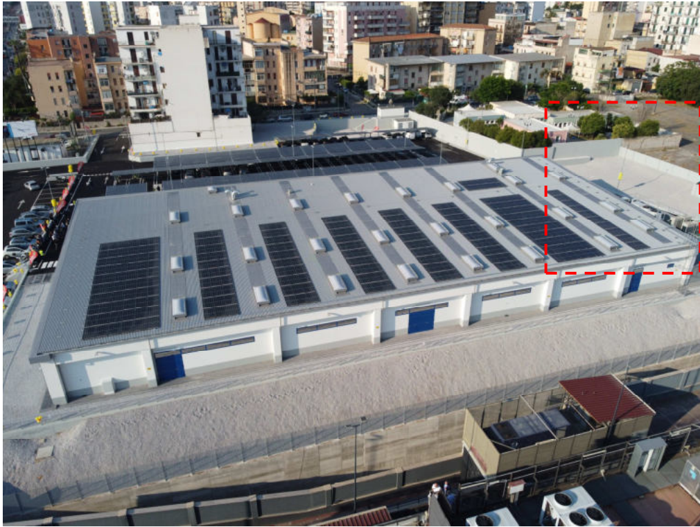
Fig. 15/a - Sistemazione attuale della scarpata sull'area LIDL nel fronte N-NO
