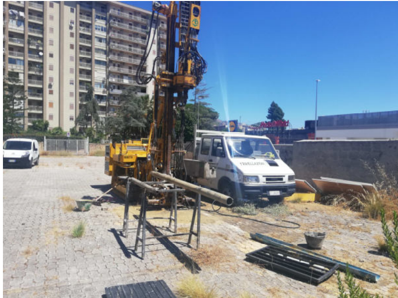
Foto 1 – Posizionamento trivella sul foro di sondaggio n. 1 (S1)
